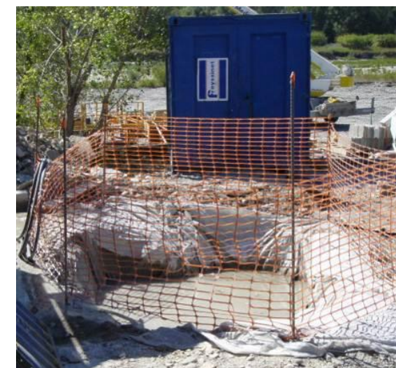
Figure 84 : Exemple de fosse à béton (Source : SYTRA 2012)
